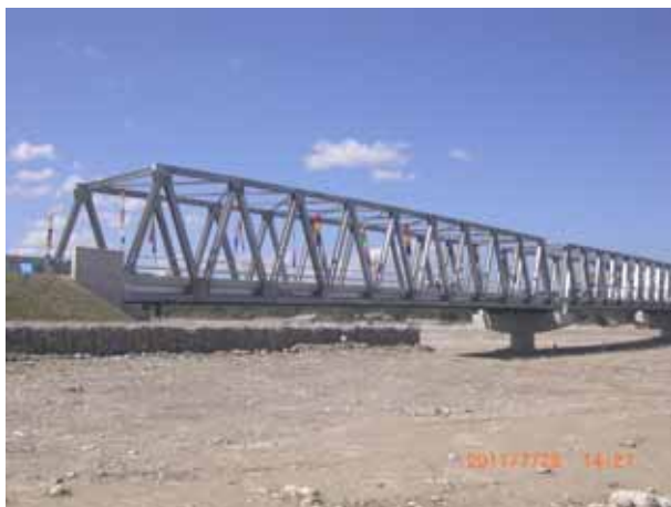
完成したモラ橋
