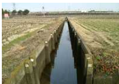
写真-3 現状の農業用排水路 (コンクリート柵板)
