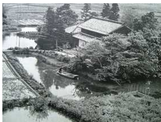
写真2 堀に囲まれた屋敷(町内)
