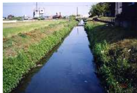
写真-4 自然な土羽水路 (安八町内)
